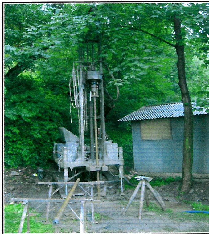
Usytuowanie i wiercenie otworu GI-2 u podnóża skarpy
