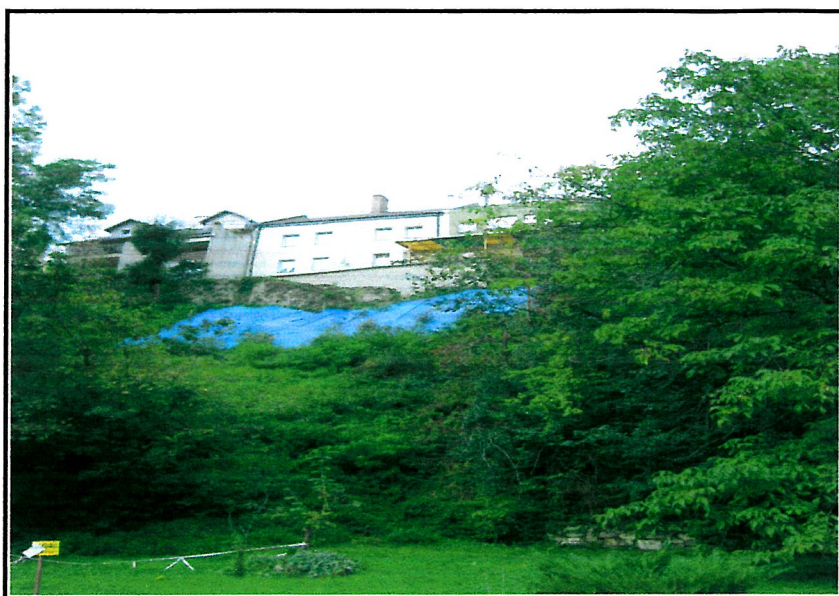
Widok ogólny osuwiska w obrębie skarpy wraz z zabezpieczeniem plandeką przed infiltracją wód wg stanu na wrzesień 2012r.
