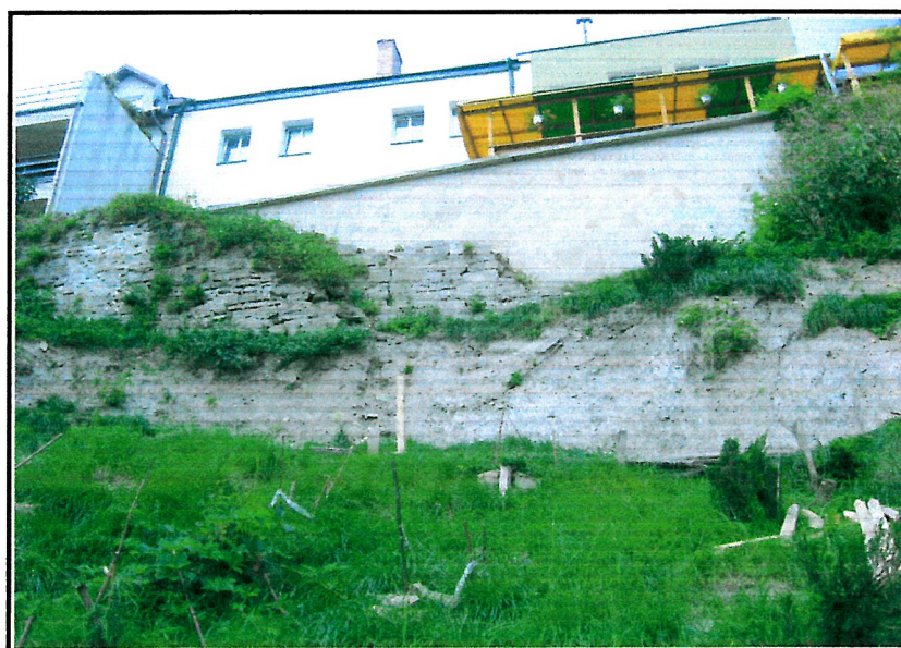
Krawędź górna osuwiska w obrębie skarpy wg stanu sierpień.2011r.
