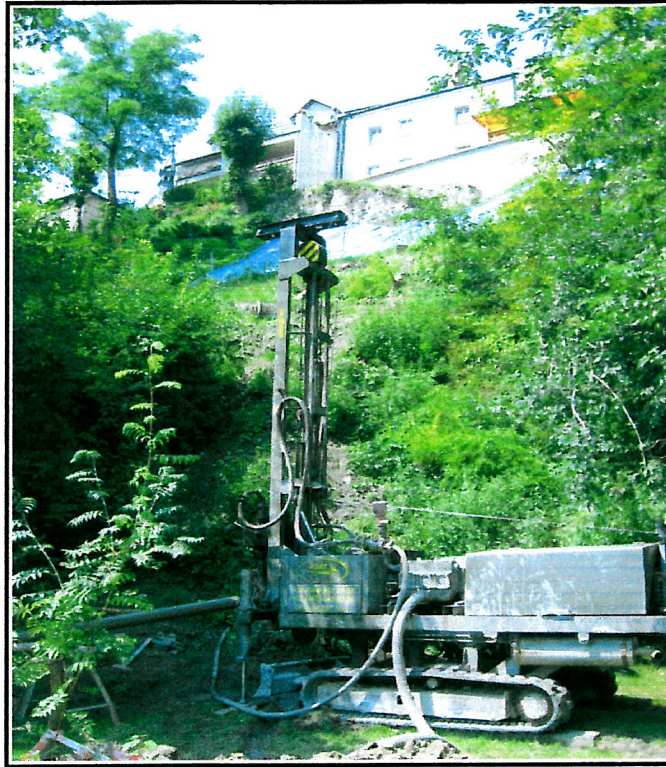
Usytuowanie i wiercenie otworu GI-1 u podnóża skarpy
