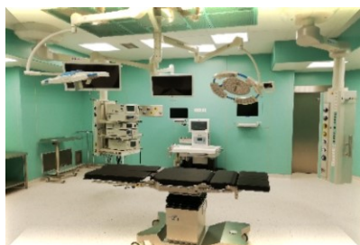
Blok operacyjny po realizacji projektu
