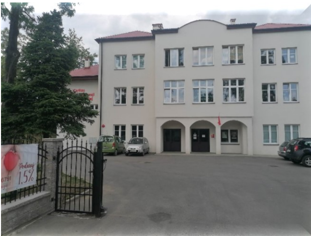
Budynek Domu Kultury po rewitalizacji
