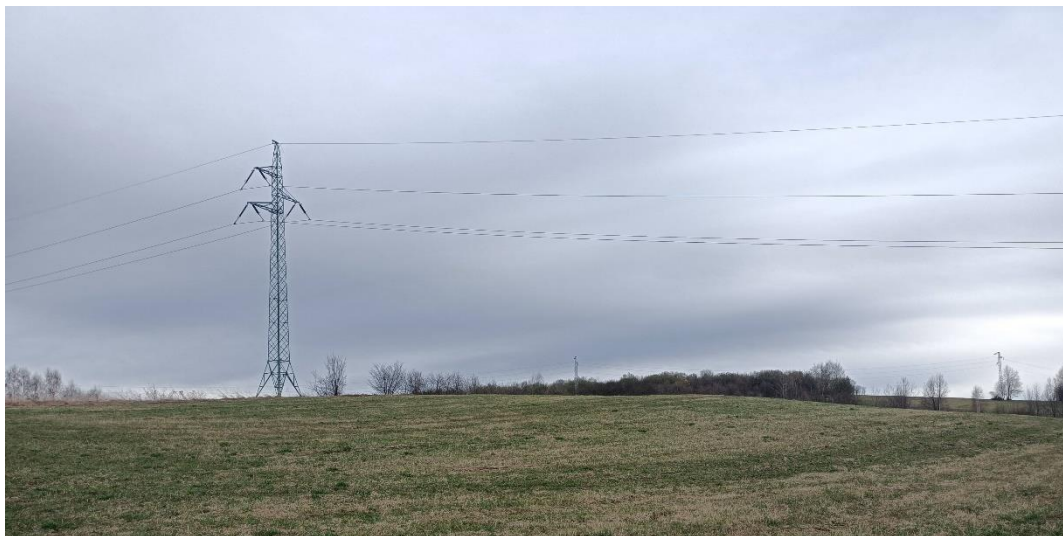
Ryc. 12 Jedna z linii elektroenergetycznych w granicach opracowania
